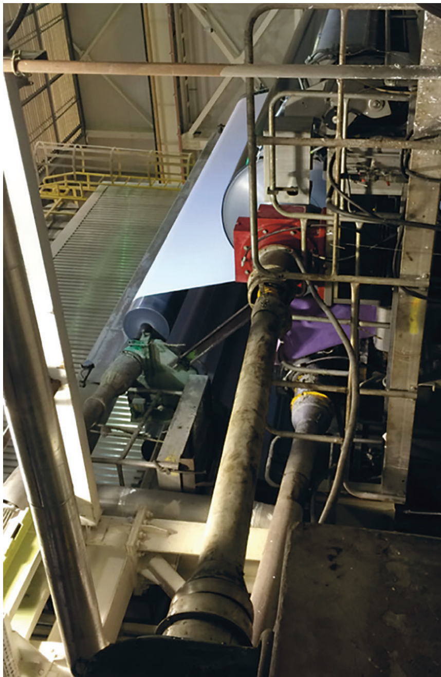
Фото 5. Поверхностная проклейка БДМ-7
